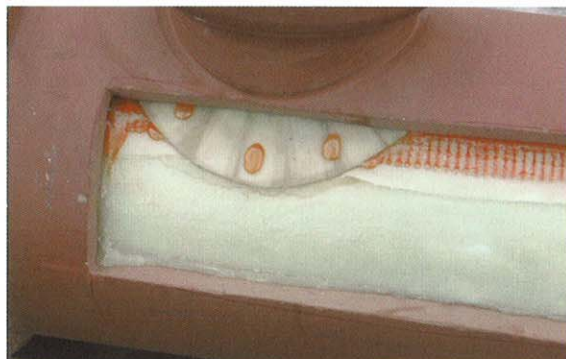
▲本管ライニング材 硬化状況(一本化更生時)
