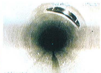
▲本管と取付管の接合部
