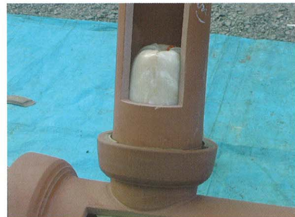
▲エア加圧反転挿入状況
