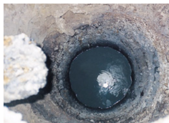
老朽化したマンホール。
