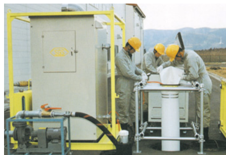
本管ライニング施工中。
