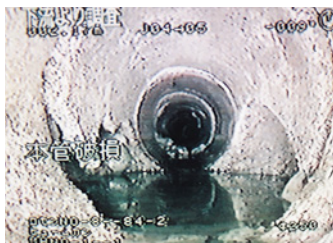
老朽化で破損した本管。
