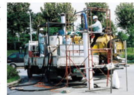
省スペースでの施工が可能。
