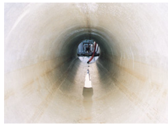
ICPブリース工法で施工後。
