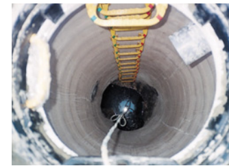
ICPブリース工法マンホールライニング施工後。
