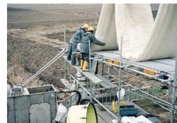
大口径本管ライニング施工中。
